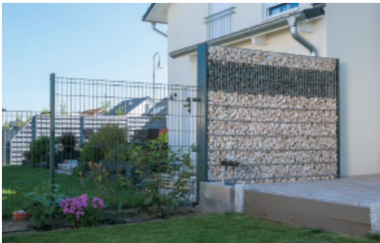
Gabionen Die Gitterboxen sind der Trend beim Zaunbau. Mit Steinen gefüllt, bieten sie einen ästhetisch sehr anspruchsvollen Wind- und Sichtschutz
