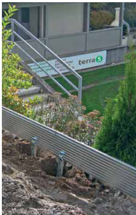
Bei der Böschungssicherung helfen Erdanker den Hangdruck aufzufangen und geben dem Profil zusätzlichen Halt.
