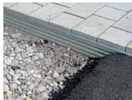
Universität Bamberg: Bei geteerten Flächen wird das Profil in Beton versetzt und der Teer bis zur Oberkante des Profils gezogen.
