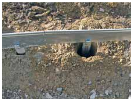
Zum Setzen der Erdanker wird entweder mit einem Erdbohrer ein Loch in das Erdreich gebohrt oder die Anker werden direkt in die Erde eingeschlagen.
