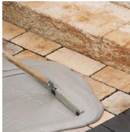
Das tubag Komplettsortiment für Ihren Garten: Drainagemörtel, Haftvermittler oder Fugenmörtel für Pflaster, Platten und Polygonalplatten.
